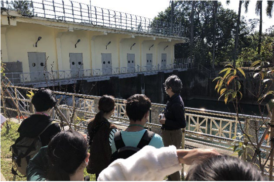
烏山頭ダム放水口での説明
